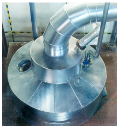
Rys. 23.8: Jedna z wyparek używanych w ZUOP-Świerk
