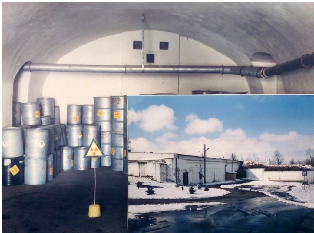
Rys. 23.11: Hala przeładunkowa i jeden z budynków dawnego fortu w Różanie
